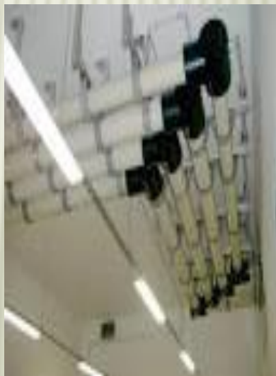
Изглед изолованих сабирница у једном постројењу
